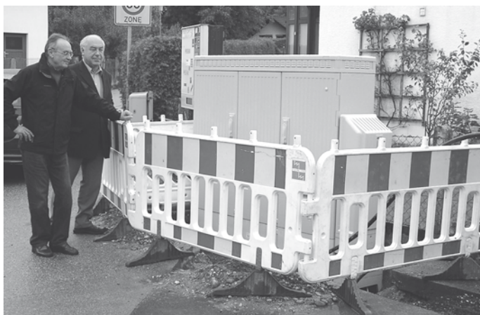
Vom Fortschritt der Bauarbeiten im Breitbandbereich machten sich Bürgermeister Joachim Wagner und der Geschäftsleitende Beamte Heinz Bauhuber ein Bild – hier in Hitzenua an einem Multifunktionsgehäuse
